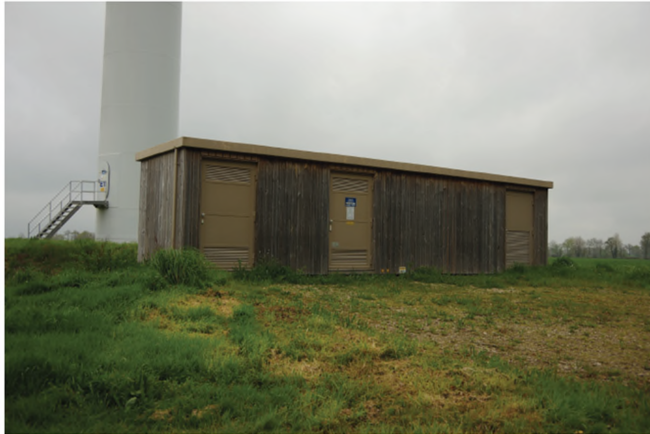
Figure 357 : Photo du poste de livraison du parc éolien de Maxent, actuellement en service
